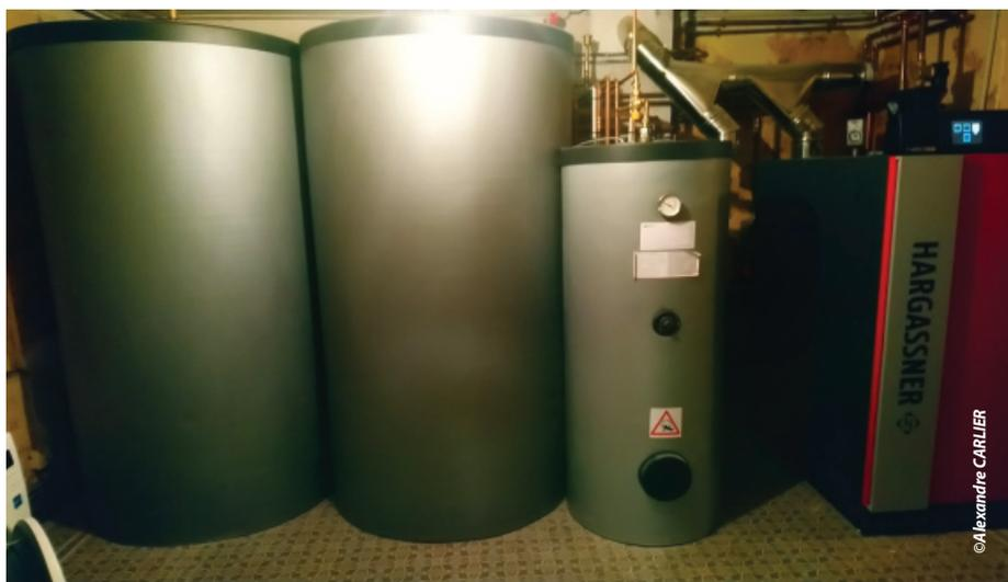
Installation chaudière bûche, les ballons tampons, l'échangeur eau chaude sanitaire et la chaudière
