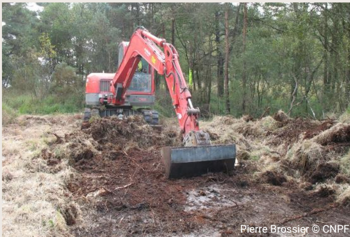
Étrépage d'une tourbière à l'aide d'une mini-pelle
