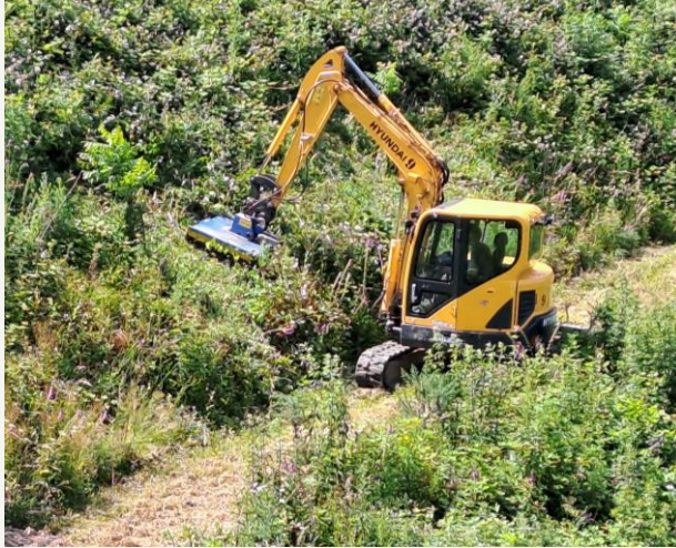
Broyage mécanisé depuis le chemin
