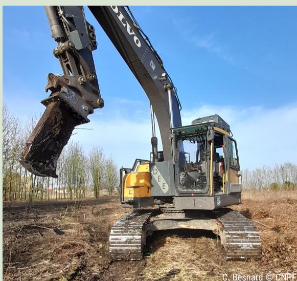
Pelle de plantation sur chenilles permettant ainsi de limiter le tassement du sol
