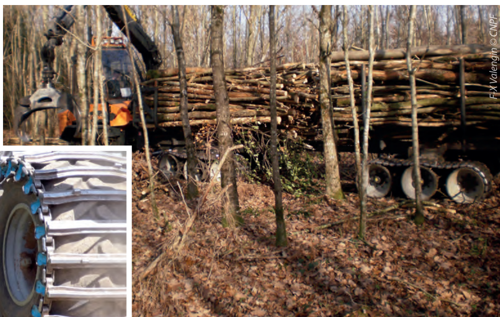
Des porteurs sur chenille avec 8 essieux limitent le tassement
