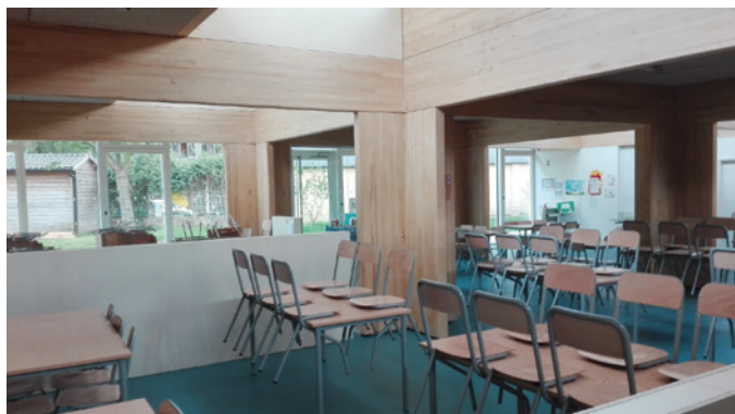
Architecte : TGMP architectes & associés – Entreprise : Ramery Construction Bois - Dalles de plancher en lames alternées de peuplier, groupe scolaire Pasteur/Dolto à Templemars
