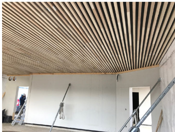
Architecte : TGMP architectes & associés – Entreprise : Ramery Construction Bois Dalles de plancher en lames alternées de peuplier, groupe scolaire Pasteur/Dolto à Templemars
