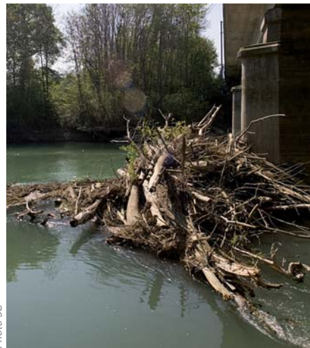
Embâcles contre une pile de pont (51).
