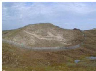
Caudeyre en cours de restauration - (Lindbergh)
