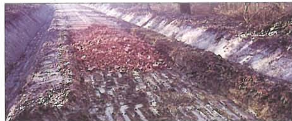
Renforcement d'une route existante
