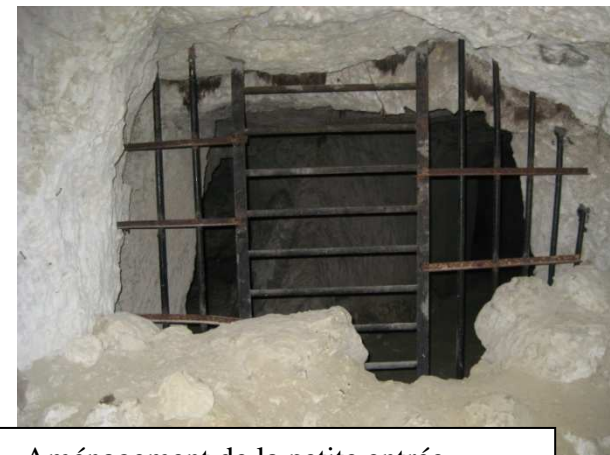
Aménagement de la petite entrée
